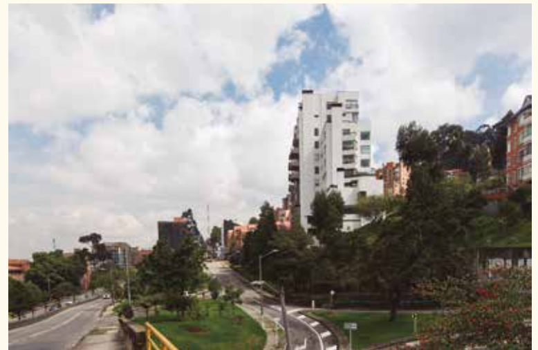
IMÁGENES DE LOS CERROS AMENAZADOS POR EDIFICACIONES Y CONSTRUCCIONES QUE CADA VEZ TOMAN MÁS ALTURA Y CUBREN MAYOR EXTENSIÓN EN NUESTRAS MONTAÑAS. FOTOS: CARLOS LEMA-IDPC
